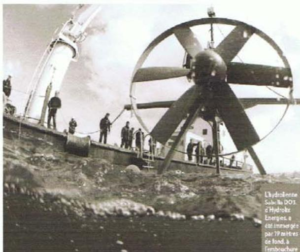
L'hydrolienne SOLO DO3 d'Hydrobr Energy a été immergée par 19 mètres de fond à l'embouchure de la rivière Odet, dans le cadre du projet Marenergie.
